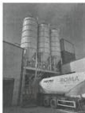
Fig.11 Imagine cu modul de stocare al cimentului
