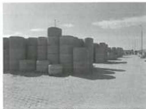
Fig.18 Imagine cu modul de depozitare al elementelor prefabricate de canalizare (tuburi)
