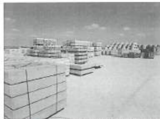
Fig.20 Imagine cu modul de depozitare al elementelor prefabricate de vizitare (cămine și capace de cămin)
